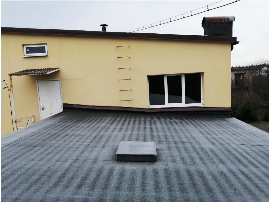
рис. 8. Заделанная вентиляционная шахта, кровля над 1-м этажом
