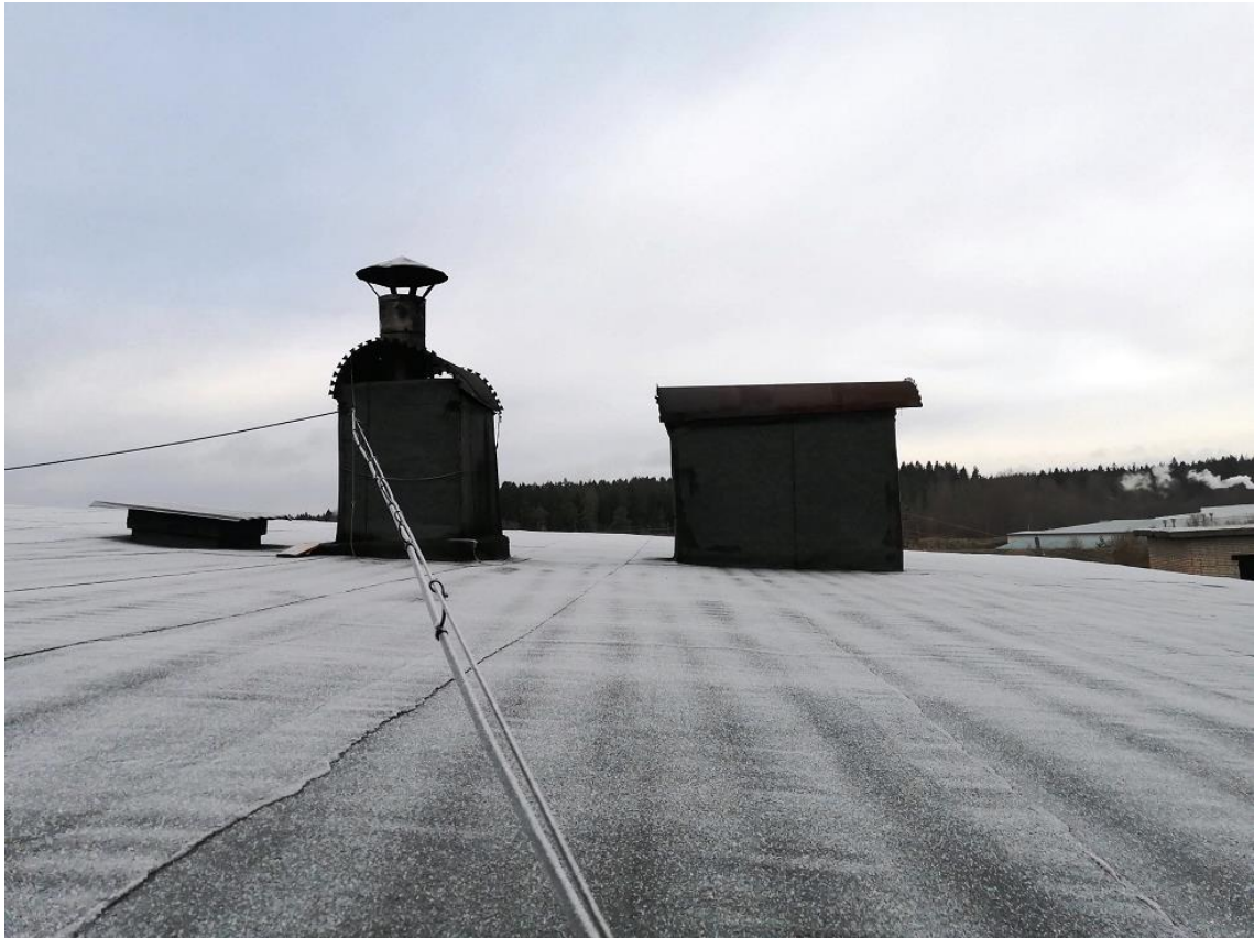
рис. 10. Вентшахты, кровля над 2-м этажом
