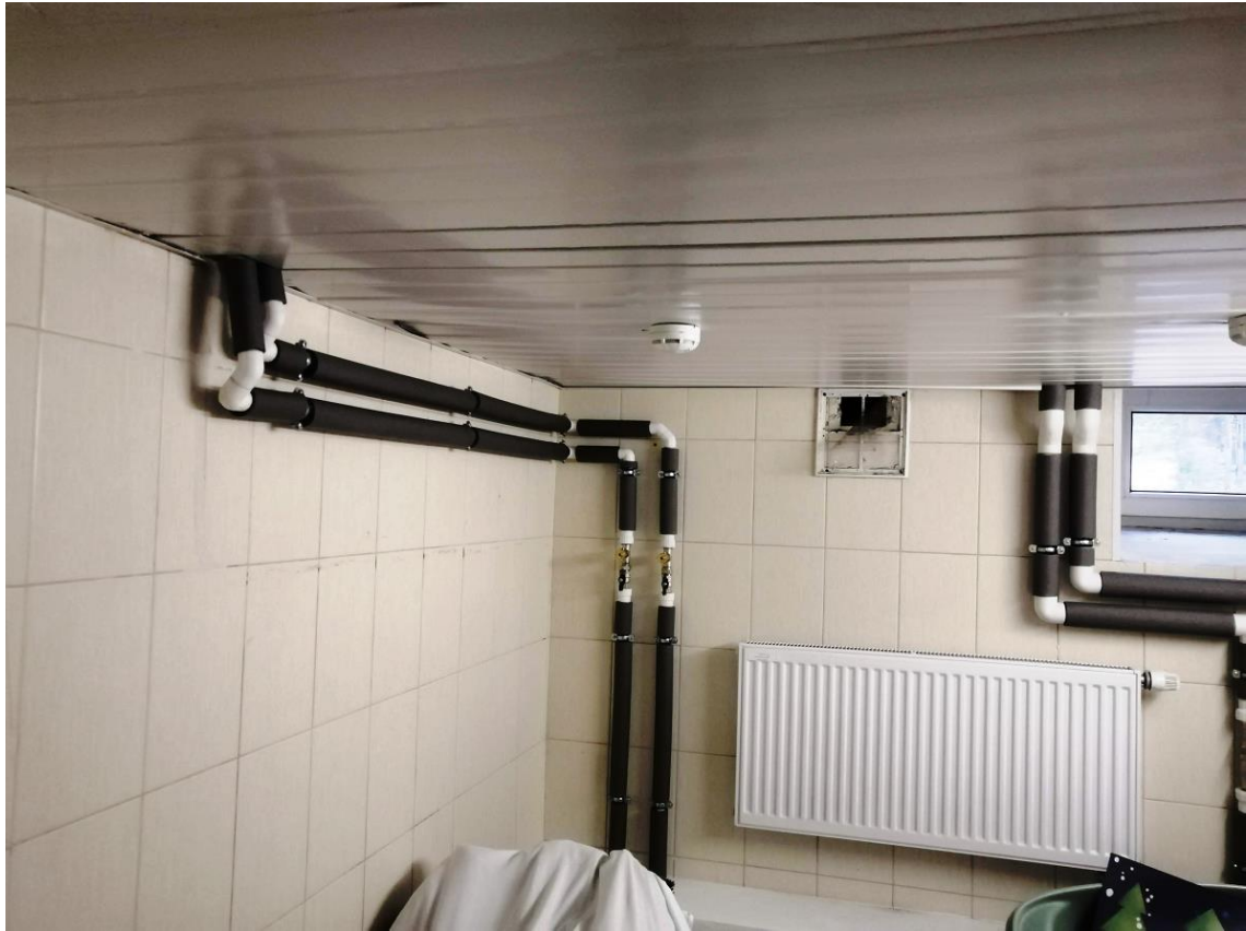
рис. 15. Рамка от решетки системы перетока, кладовая (п.33, подвал)
