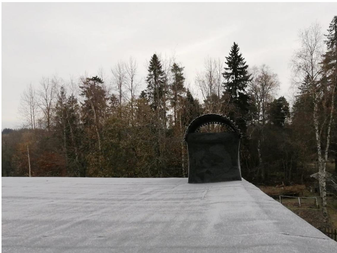
рис. 9. Вентиляционная шахта, кровля над 2-м этажом
