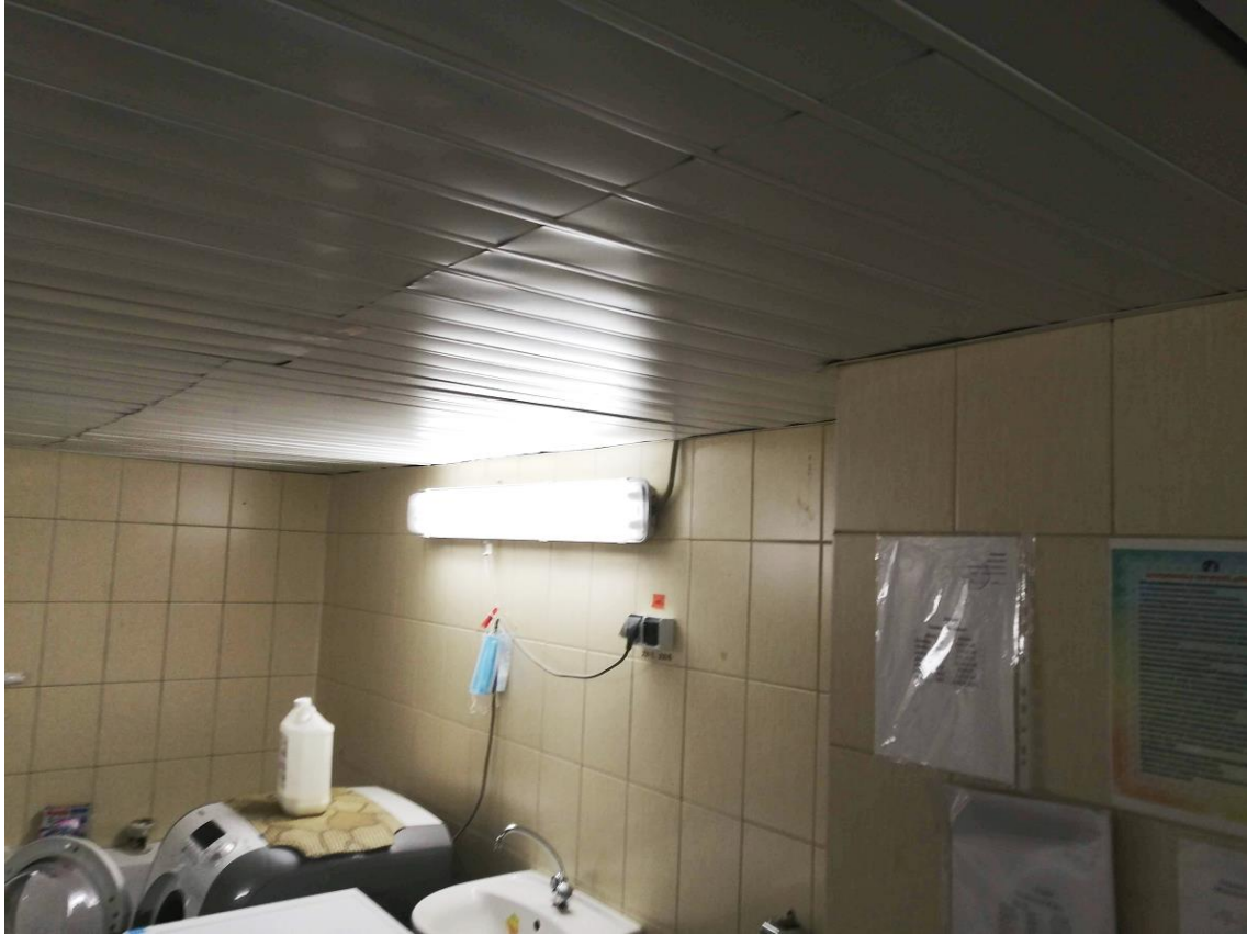
рис. 2. Прачечная (п.30, подвал)
