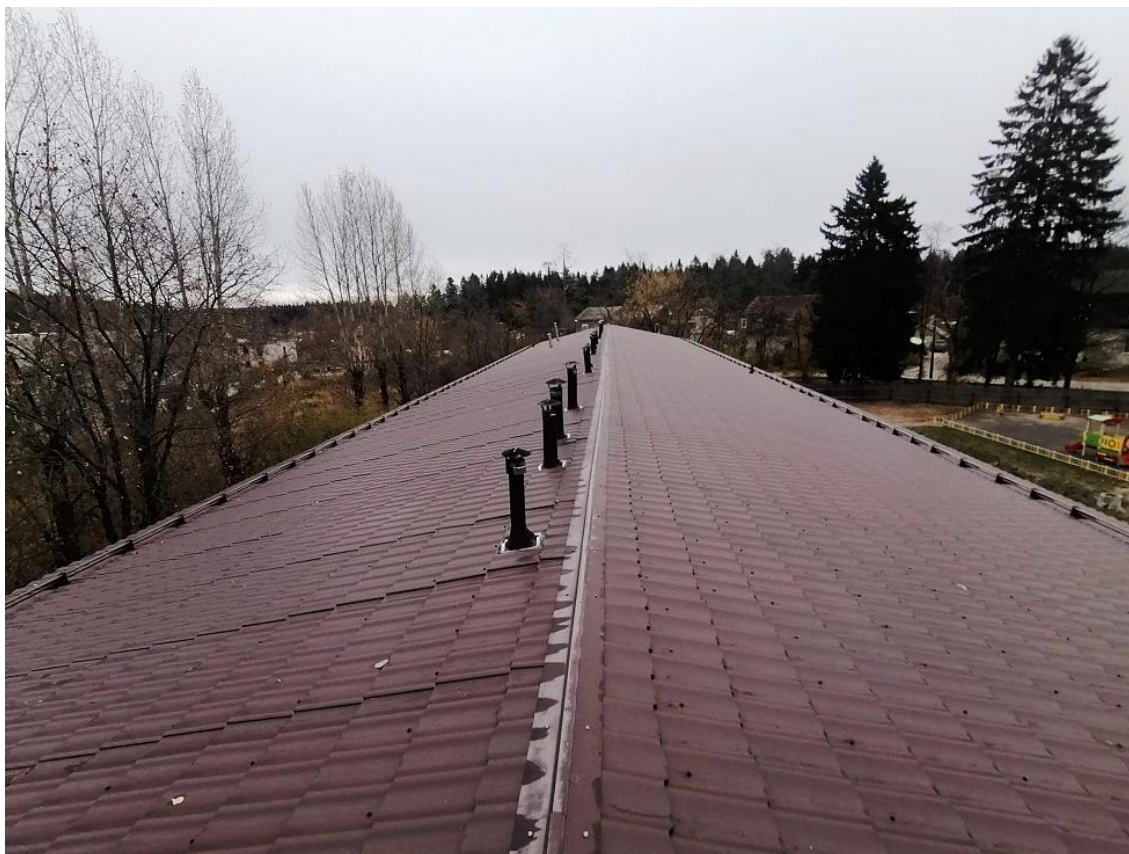
рис. 14. Воздуховоды на кровле
