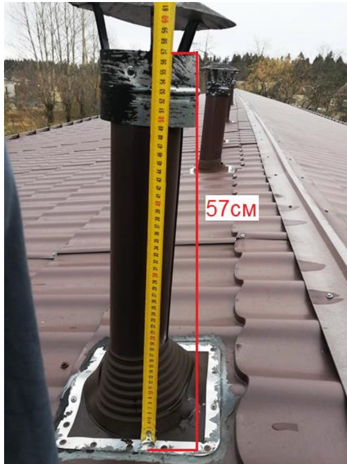
рис. 17. Высота воздуховодов над уровнем кровли
