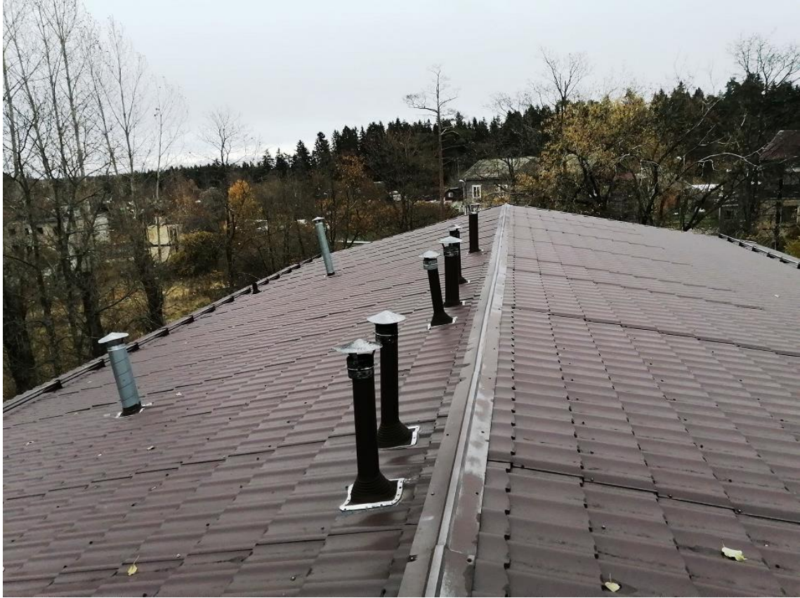
рис. 15. Воздуховоды на кровле
