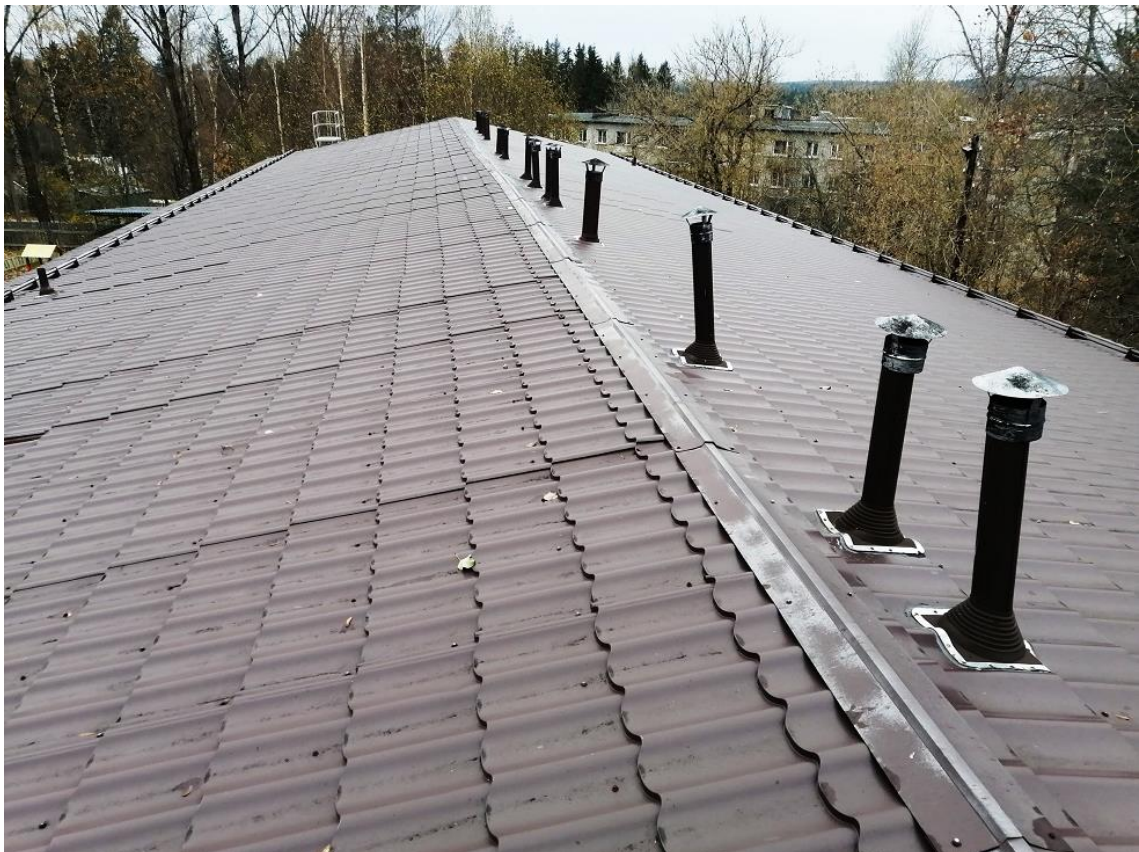
рис. 16. Воздуховоды на кровле
