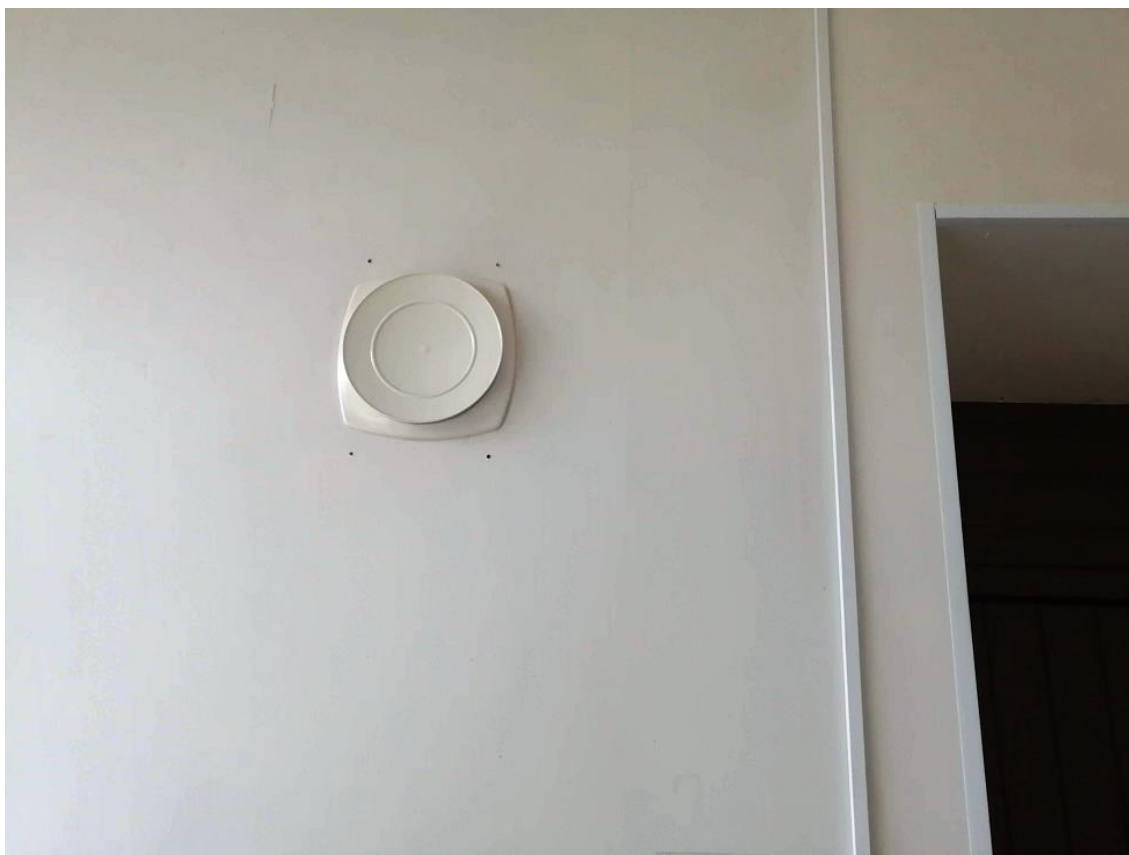
рис. 21. Система ПЕ: клапан инфильтрации воздуха типа КИВ-125, сушильная (п.21, 1-й этаж)
