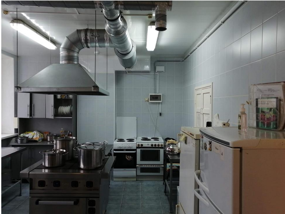
рис. 1. Вытяжная система В1, кухня (п.16, 1-й этаж)
