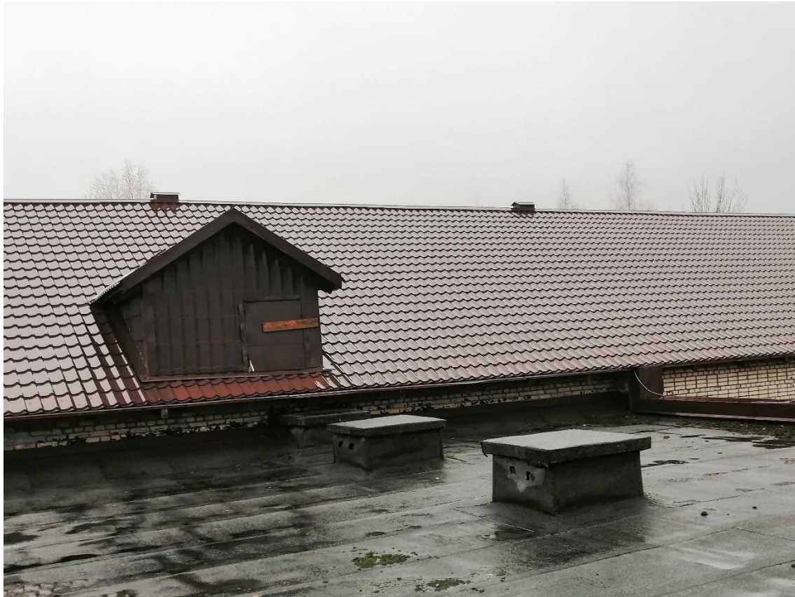
рис. 49. Три вентиляционные шахты над переходной частью здания
