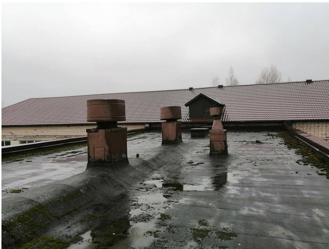
рис. 48. Вентшахты с дефлекторами над переходной частью здания
