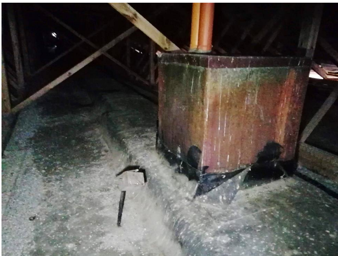
рис. 41. Вентканалы на чердаке с вентиляцией №1, чердак над 3-м этажом
