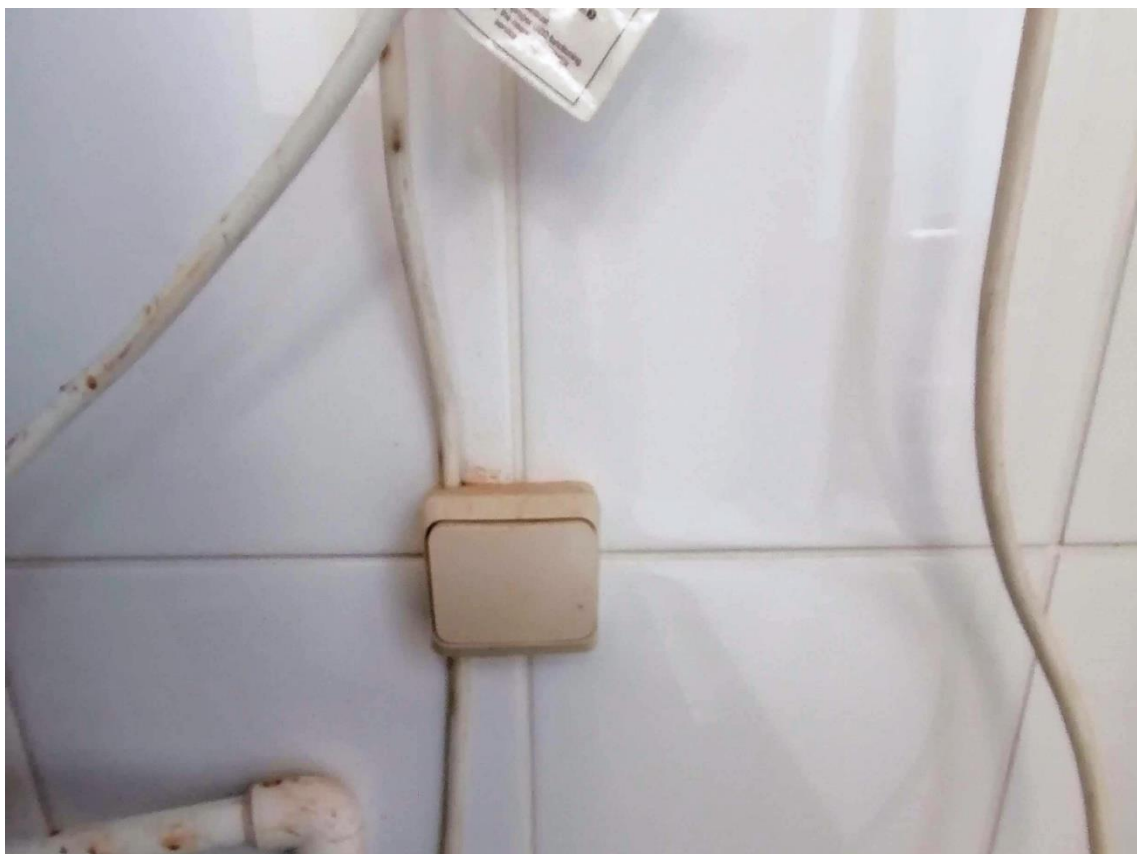
рис. 13. Клавиша управления вентилятором системы В1, моечная (п.38, 2-й этаж)
