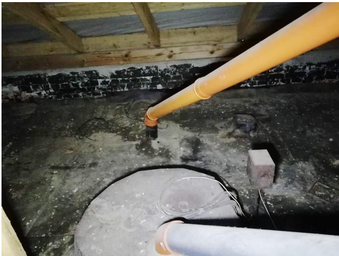
рис. 38. Заблокированная шахта над туалетами и кладовыми, чердак над 3-м этажом
