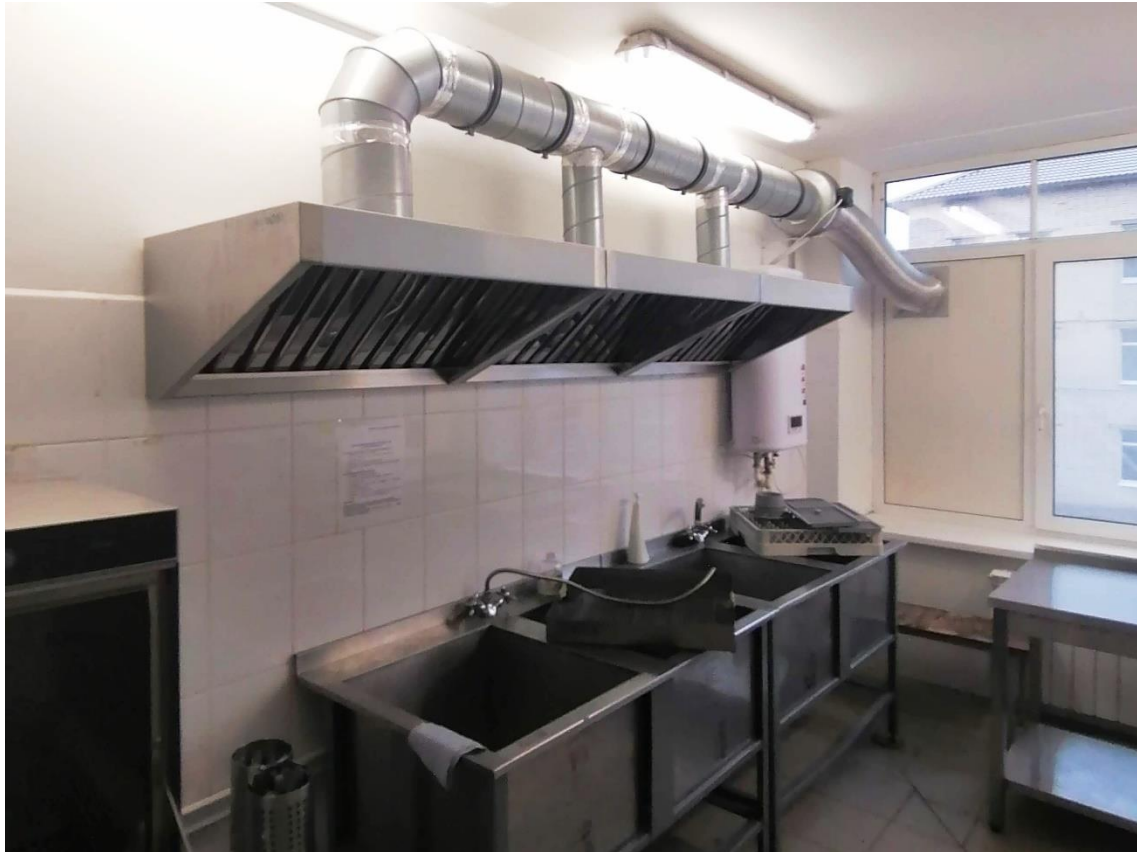
рис. 12. Вытяжная вентиляция В1, моечная (п.38, 2-й этаж)
