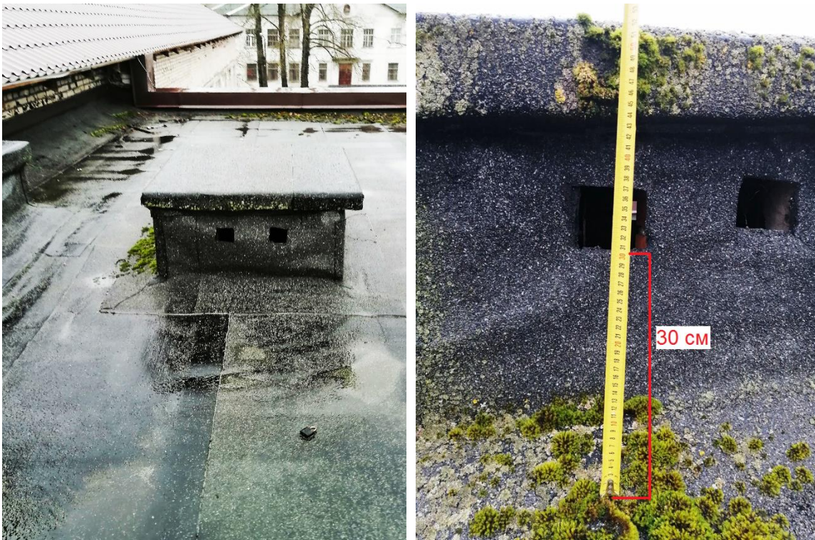
рис. 50. Три вентиляционные шахты над переходной частью здания, высота над уровнем кровли
