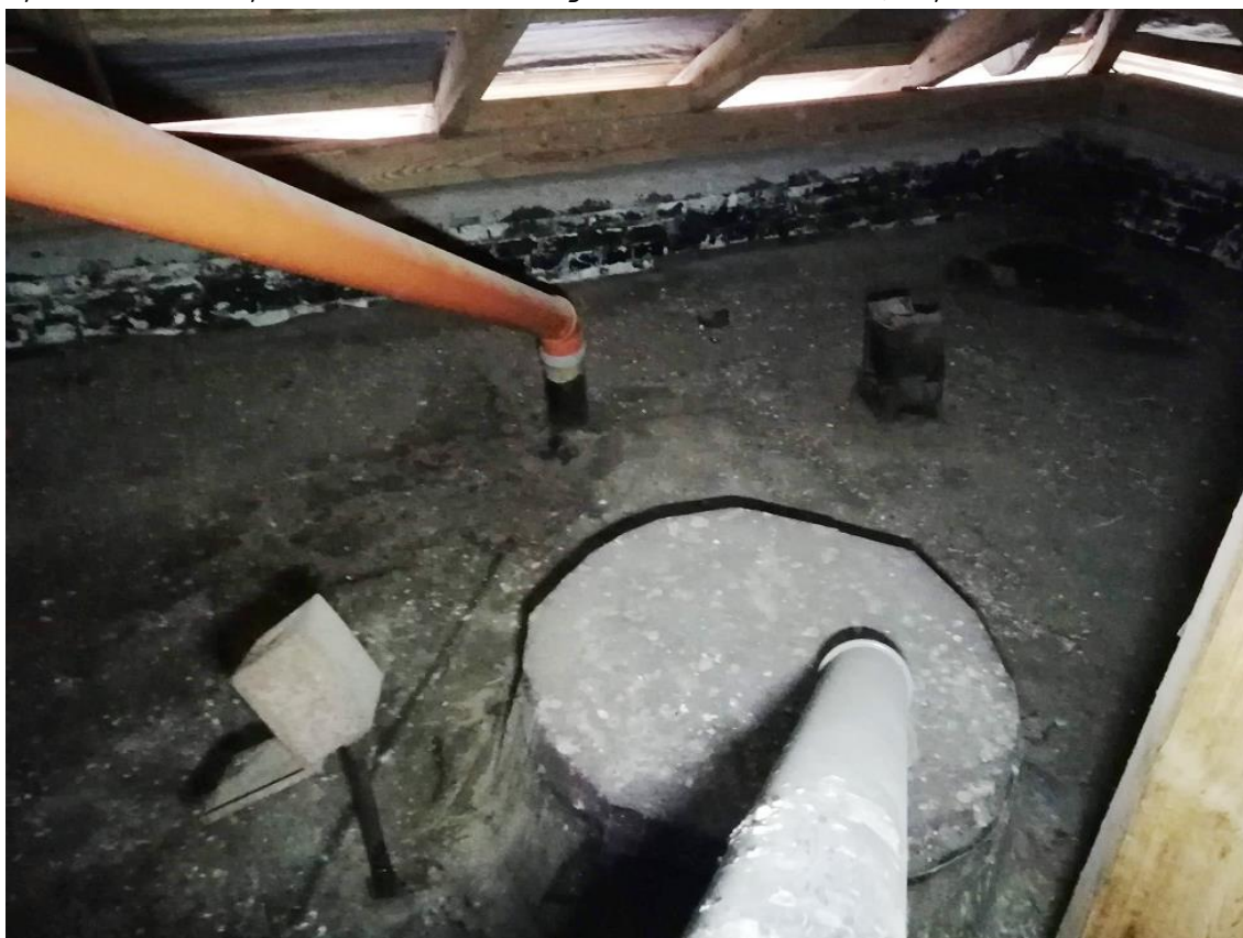
рис. 39. Заблокированная шахта над туалетами и кладовыми, чердак над 3-м этажом
