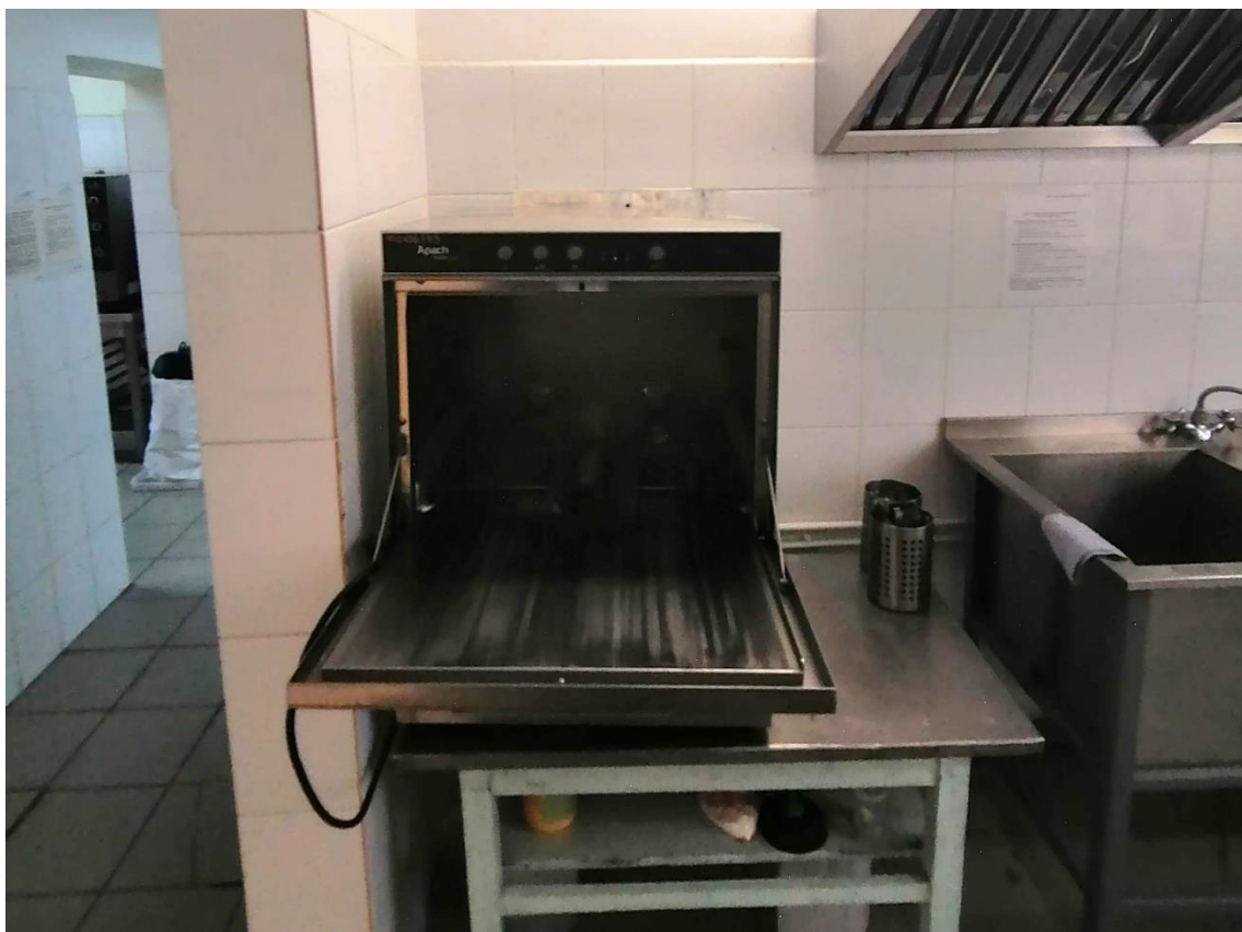
рис. 18. Посудомоечная машина не оборудована вытяжным зонтом, моечная (п.38, 2-й этаж)
