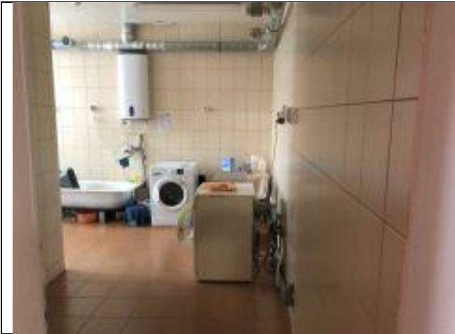
Ф. 1.31. Общий вид внутренних помещений 1-го этажа
