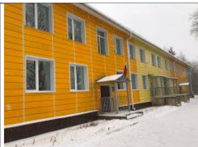
Ф. 1.2. Общий вид здания
