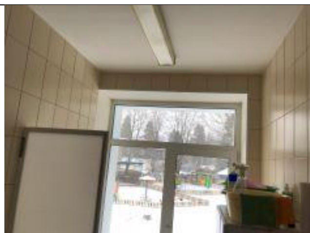
Ф. 1.60. Общий вид внутренних помещений 2-го этажа
