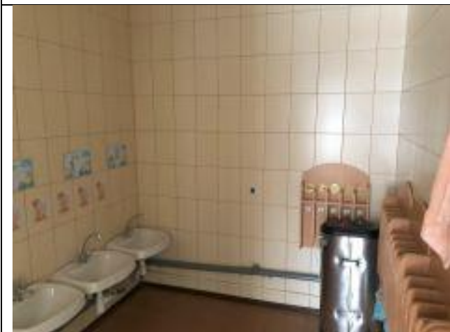
Ф. 1.45. Общий вид внутренних помещений 2-го этажа
