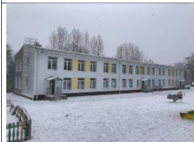
Ф. 1.5. Общий вид здания
