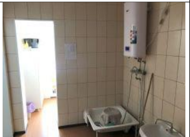
Ф. 1.46. Общий вид внутренних помещений 2-го этажа
