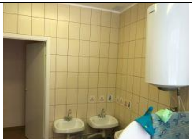
Ф. 1.30. Общий вид внутренних помещений 1-го этажа
