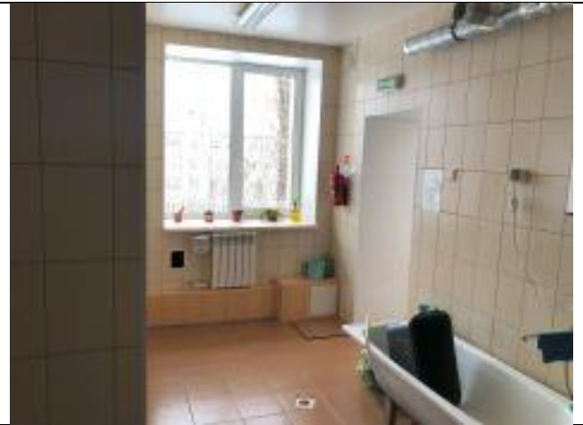
Ф. 1.32. Общий вид внутренних помещений 1-го этажа
