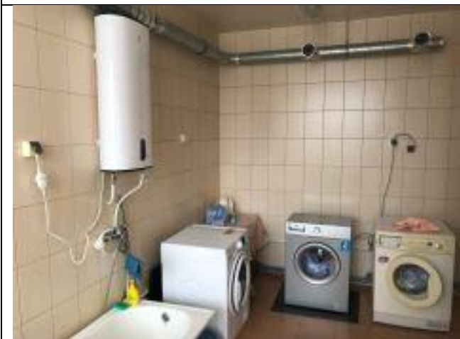
Ф. 1.33. Общий вид внутренних помещений 1-го этажа
