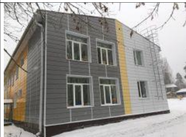
Ф. 1.4. Общий вид здания
