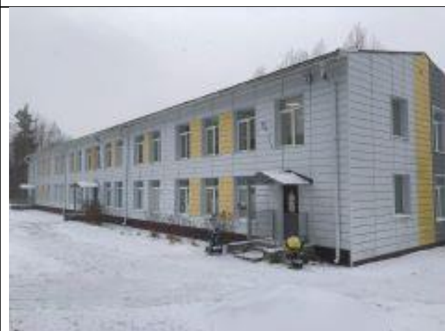
Ф. 1.6. Общий вид здания
