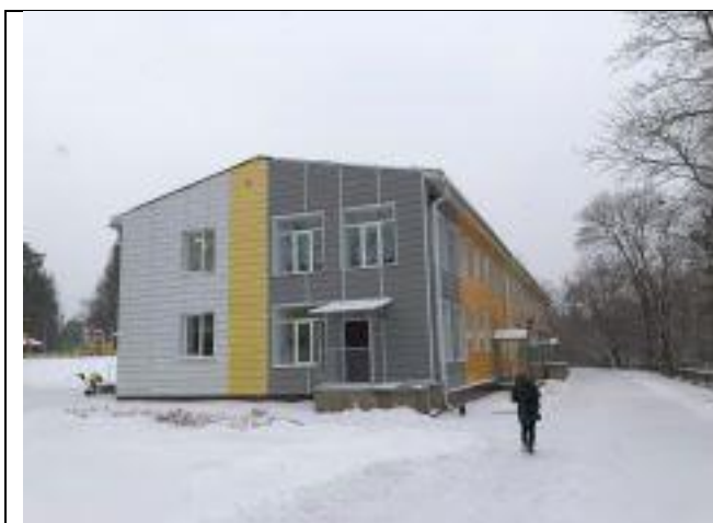
Ф. 1.1. Общий вид здания
