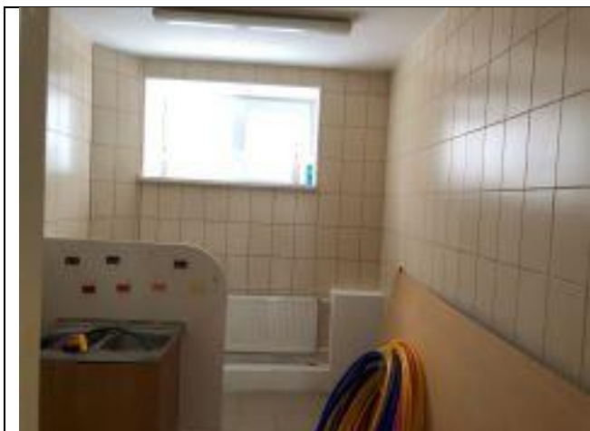
Ф. 1.19. Общий вид внутренних помещений 1-го этажа
