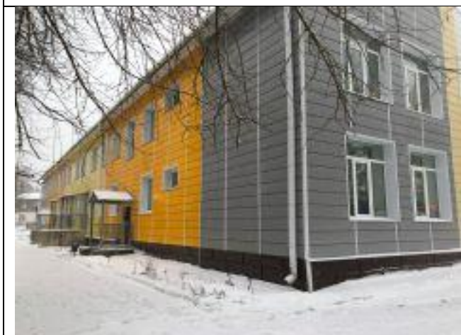
Ф. 1.3. Общий вид здания
