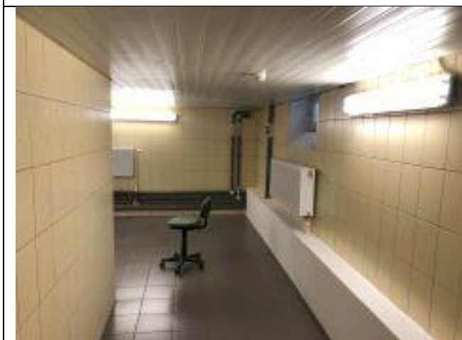
Ф. 1.17. Общий вид внутренних помещений подвала
