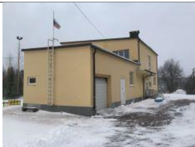
Ф. 1.2. Общий вид здания
