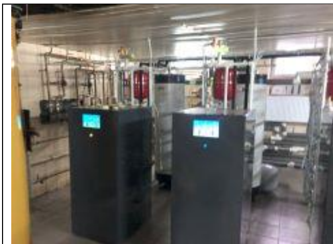
Ф. 1.13. Общий вид внутренних помещений подвала
