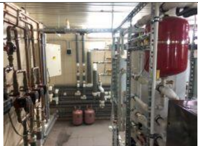
Ф. 1.14. Общий вид внутренних помещений подвала
