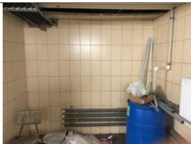
Ф. 1.12. Общий вид внутренних помещений подвала
