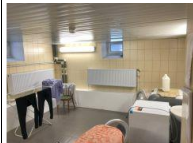
Ф. 1.15. Общий вид внутренних помещений подвала
