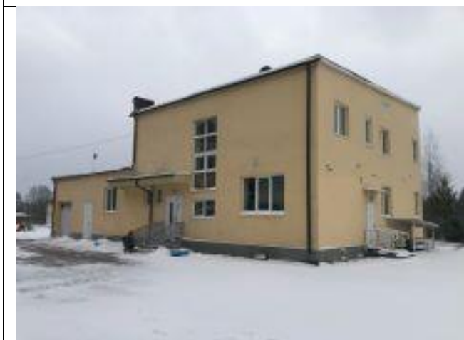
Ф. 1.3. Общий вид здания
