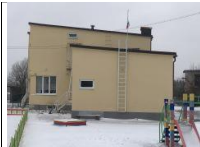
Ф. 1.1. Общий вид здания
