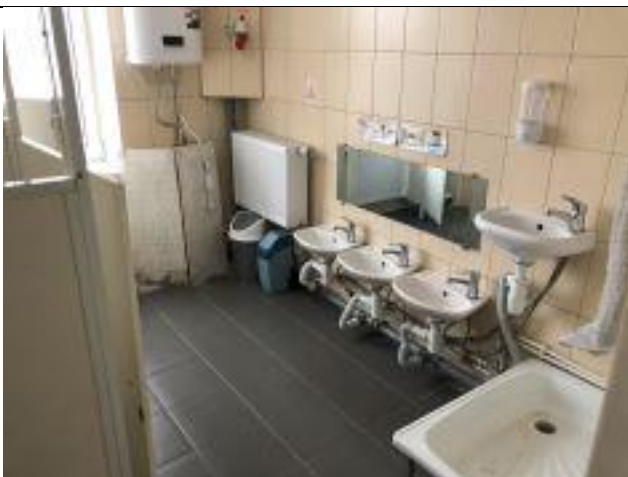
Ф. 1.41. Общий вид внутренних помещений 2-го этажа
