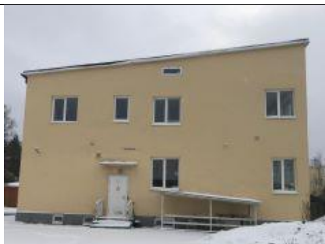
Ф. 1.4. Общий вид здания
