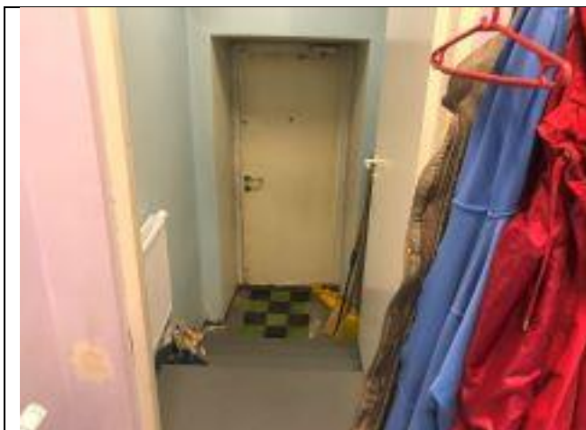
Ф. 1.31. Общий вид внутренних помещений 1-го этажа
