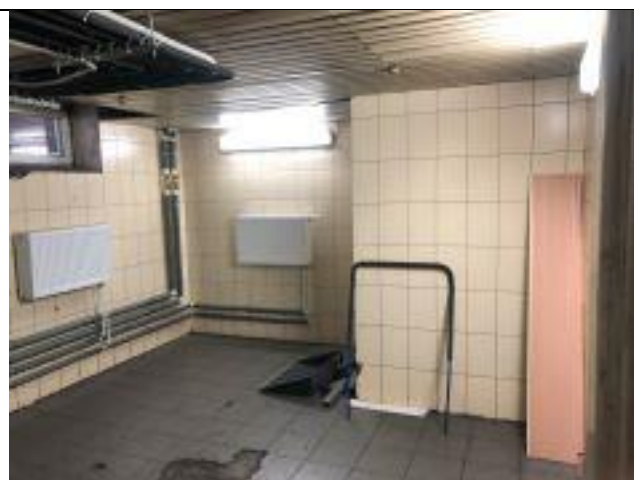
Ф. 1.10. Общий вид внутренних помещений подвала
