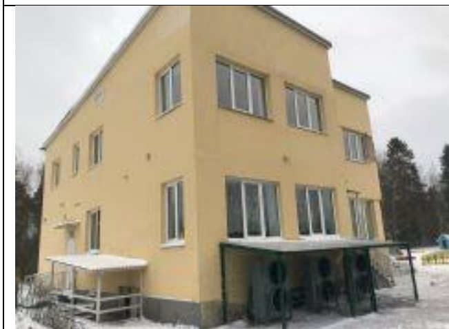
Ф. 1.5. Общий вид здания
