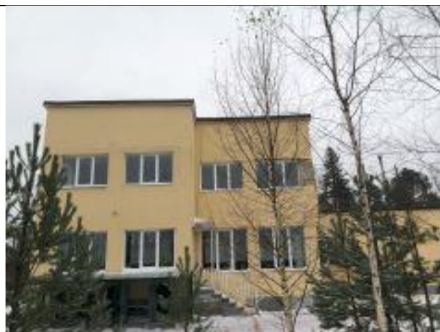
Ф. 1.6. Общий вид здания
