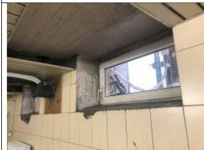
Ф. 1.11. Общий вид внутренних помещений подвала
